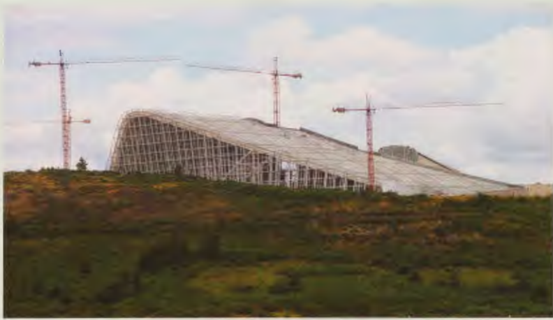
Obras en la Ciudad de la Cultura
