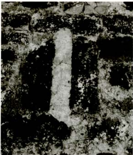
Detalle de la saetera del lado izquierdo y del vano del lado derecho de la ventana abierta con posterioridad a la fábrica primitiva
