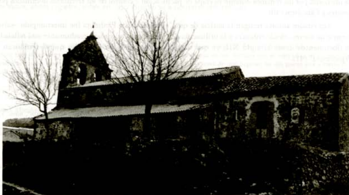
Vista general de la misma, desde el muro sur
