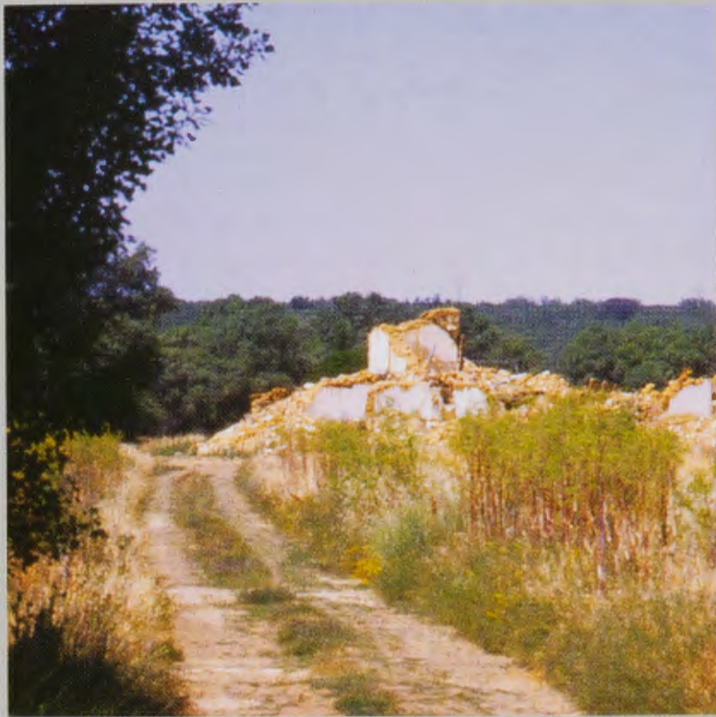
Hospital Sta.Mª de las Tiendas, Palencia. (Anton Pombo)
