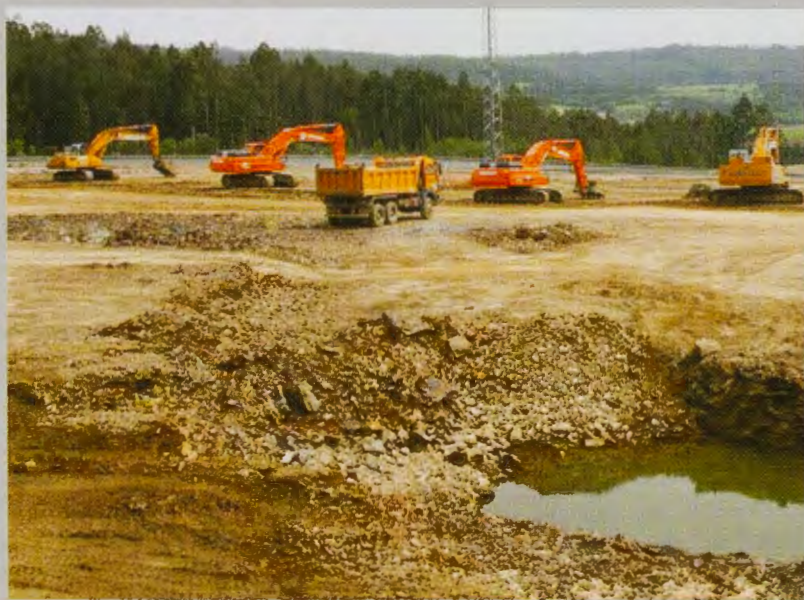
Polígono Industrial O Pino. A Coruña
