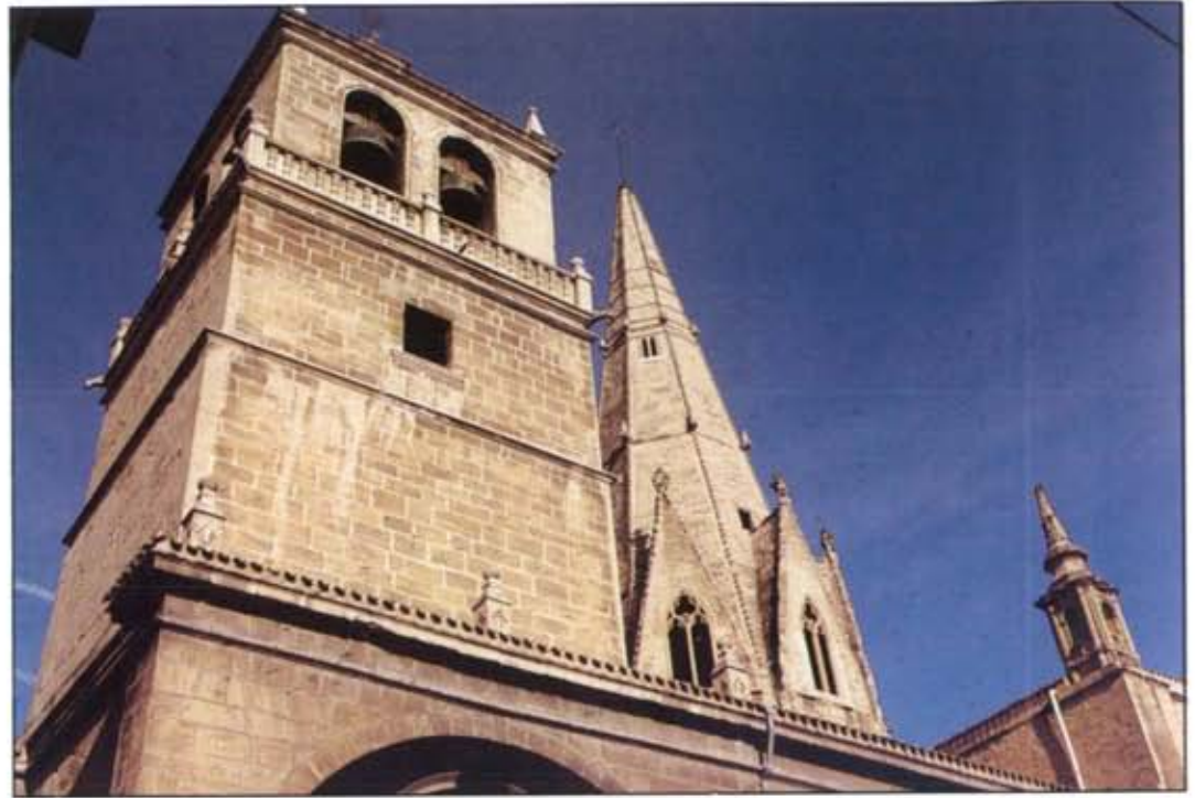
Torres de la Iglesia de Palacio. (Foto E. del Rio)
