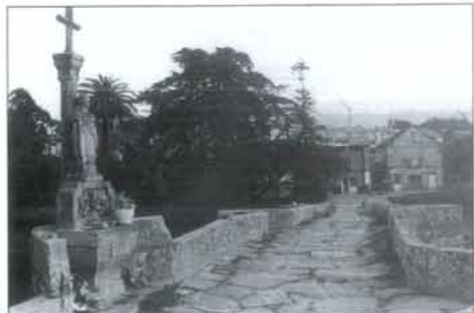
Puente de Ramallosa en el Camino portugués de la Costa
