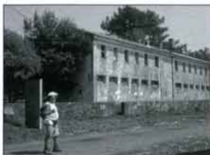
Edificio en el que se ubicará el albergue. Corcubión
