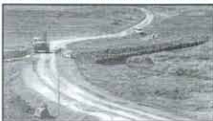
Las obras sobre el canal están casi concluidas
