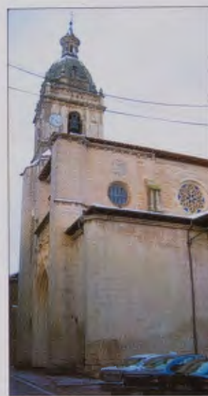
Exterior de la iglesia.
