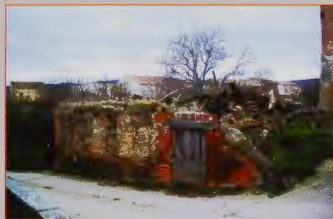
Ruinas de la casa natal de Sto. Domingo de la Calzada en VILORIA DE RIOJA
