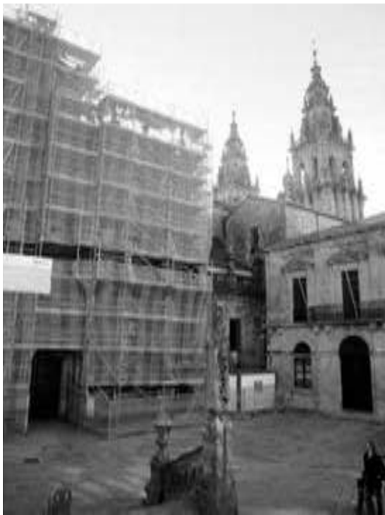
Y el 2 de enero de 2011 apareció la Puerta Francígena (Azabachería) de esta guisa. Menos mal que tenemos diez años por delante para acabar las obras.
